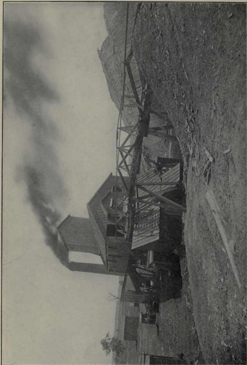
TIPPLE OF BITUMINOUS COAL MINE
